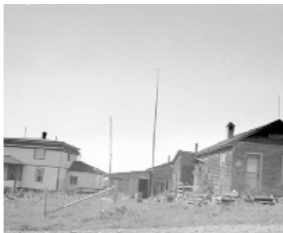
La maison Pelletier et la maison du département de la santé (gauche) à Cléricy. 1947.
