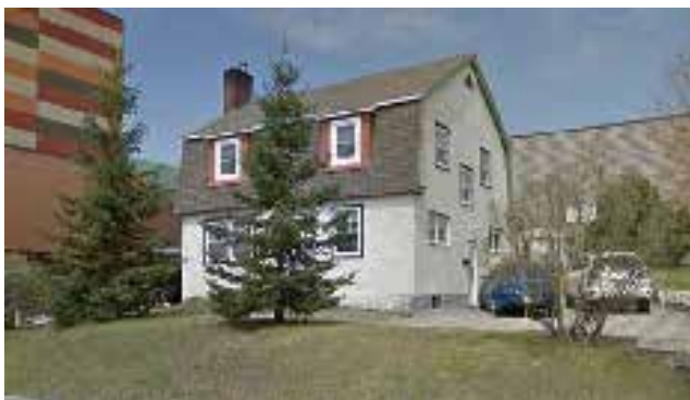
38, avenue Frédéric-Hébert, ancien presbytère anglican All Saint.
