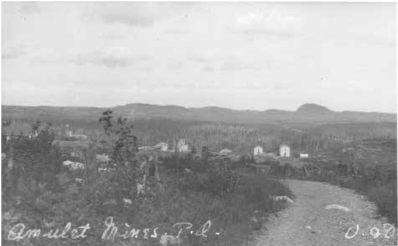
Vue d'ensemble du site de la mine Amulet. Entre 1930 et 1935.
