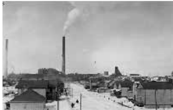
Vue de maisons de la 8 e rue et des installations de la Noranda, avec ses cheminées et ses chevalements. 1935. Fonds ministère des Ressources naturelles. E20,S2,SS1,P508. BAnQ Rouyn-Noranda.
