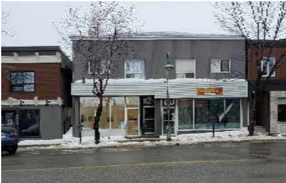
Une devanture commerciale ayant subi plusieurs transformations, dont un recouvrement du revêtement d'origine et de l'entablement. Un lampadaire en forme de cloche rappelle le modèle d'origine. Enclume, 2023.
