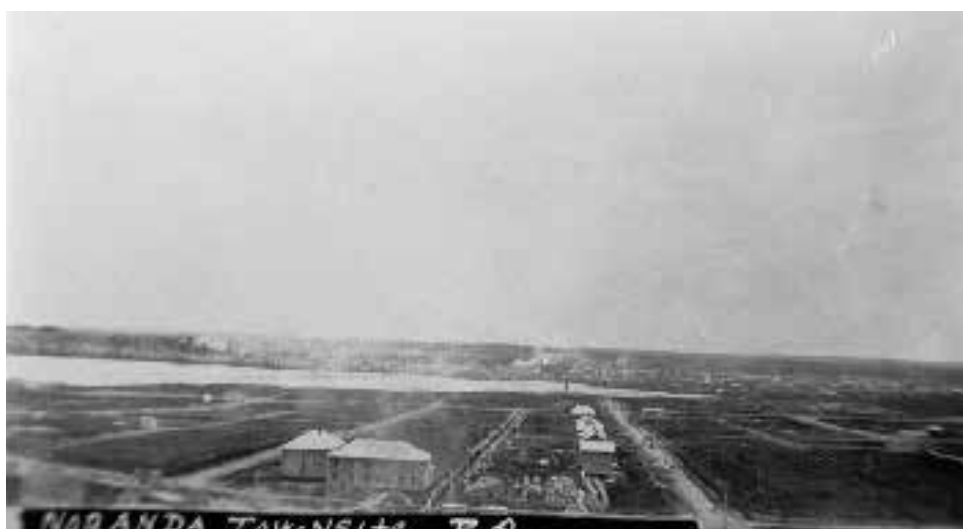
Les débuts de la construction de Noranda. Vers 1926-1927.
