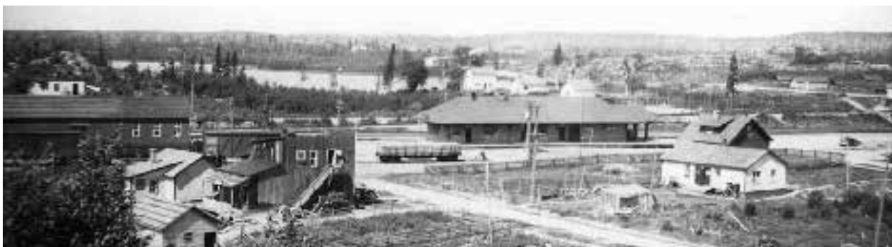
Vue de la gare du Temiskaming & Northern Ontario (T&NO) située à l'extrémité ouest des rues Perreault et Taschereau, près de l'actuelle avenue Québec. Entre 1928 et 1935.
