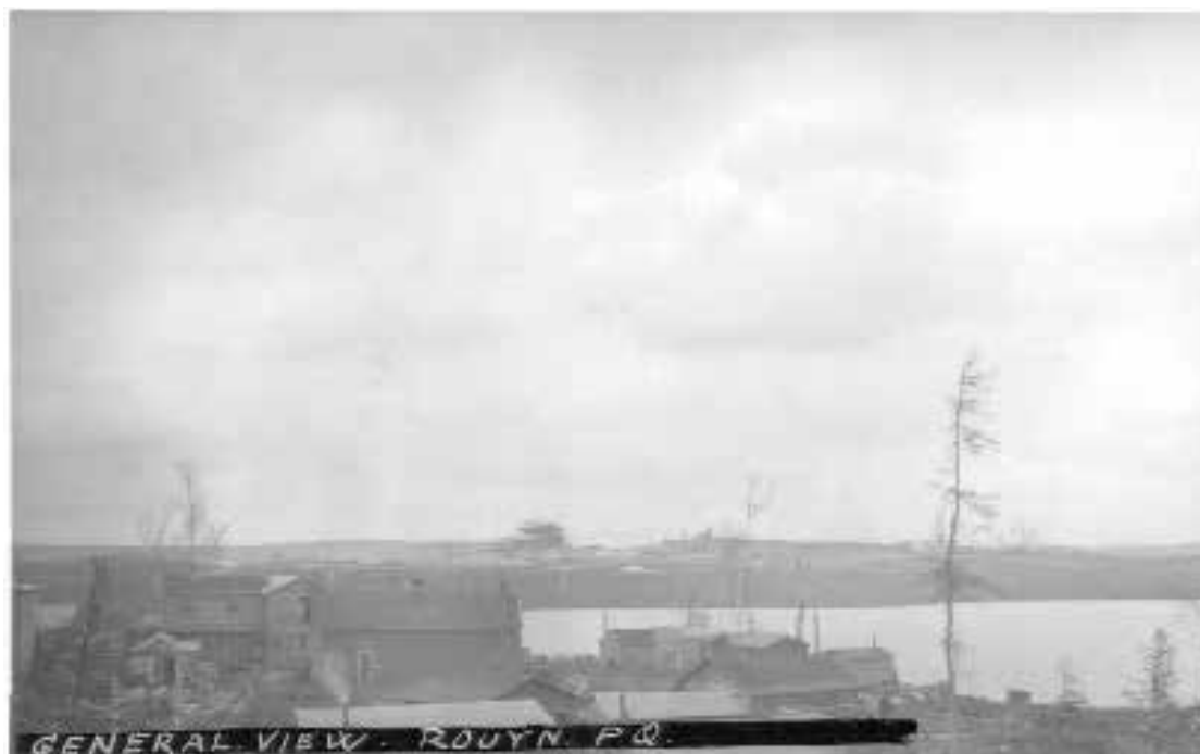
Vue de bâtiments situés à Rouyn sur le bord du lac Osisko et avec en arrière-plan les débuts des travaux de la construction du haut-fourneau de la mine Noranda. Vers 1926.
