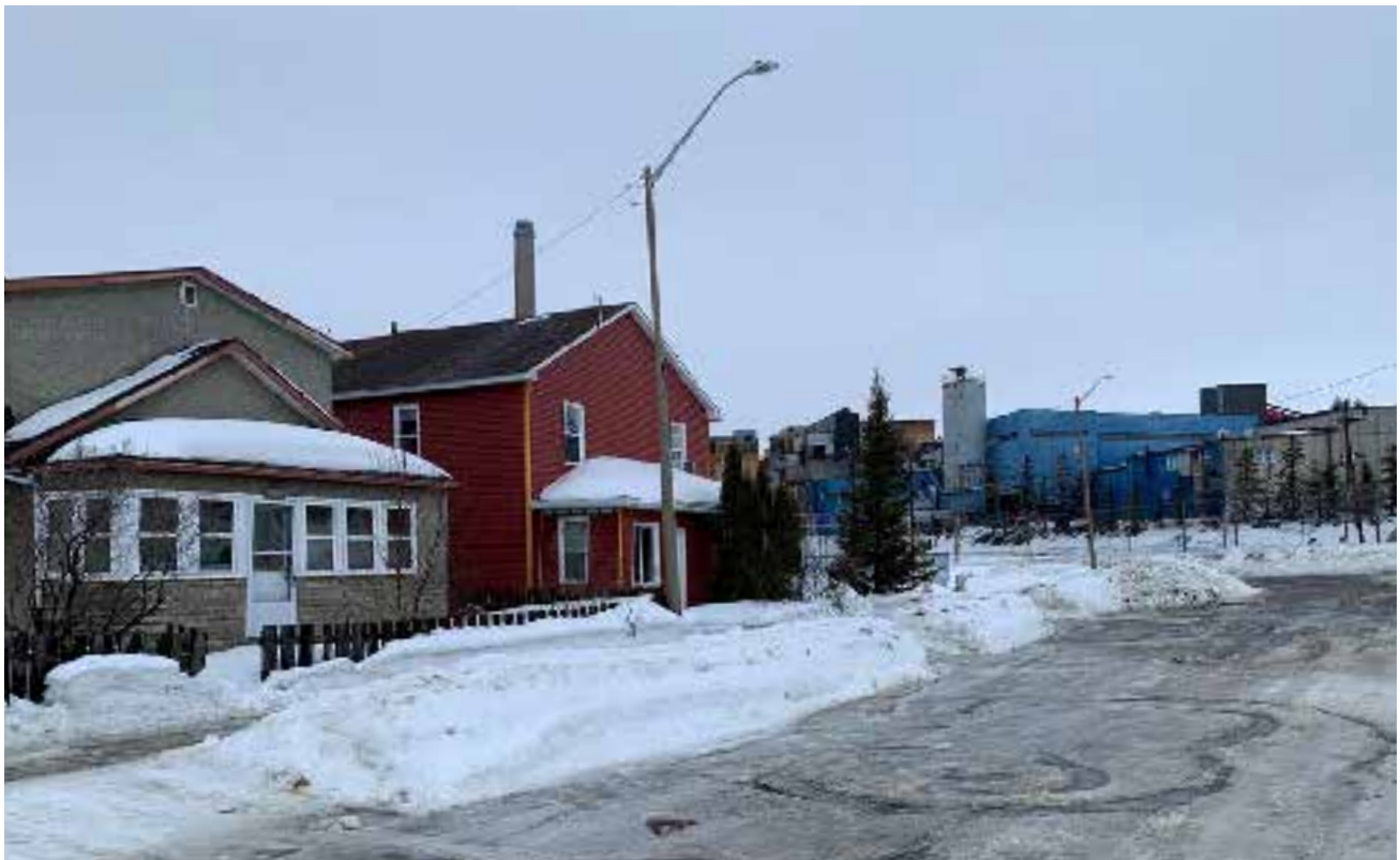
Alignement résidentiel sur le chemin Trémoy. Les marges latérales laissent peu de place entre les bâtiments. Enclume, 2023.
