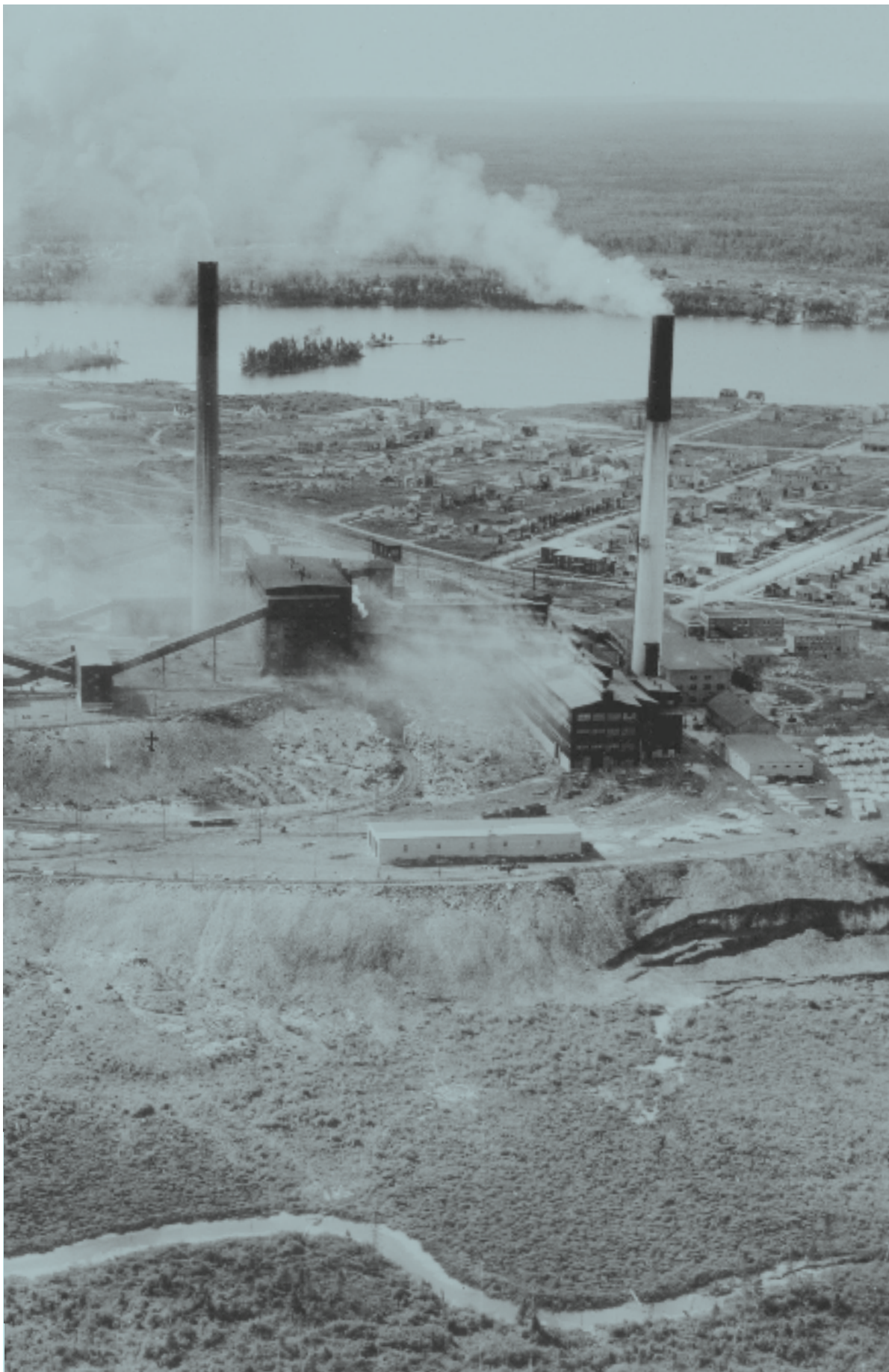
Vue aérienne de la mine Noranda (vers le sud) entre 1933 et 1937. On aperçoit les deux cheminées, les convoyeurs couverts et les puits d'extraction. Fonds Canadien National. 08Y, P213, P445. BAnQ Rouyn-Noranda.
