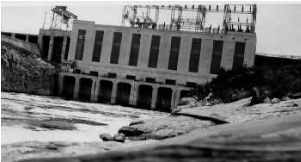
Le barrage et la centrale de Rapide VII.
