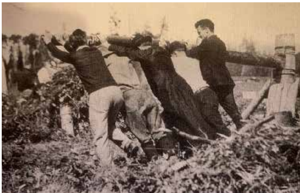
Un missionnaire colonisateur aide ici au défrichement du lot d'Alexandre Chamberland à Rollet en 1932. Il pousse avec les autres sur le cabestan qui sert à arracher les souches.
