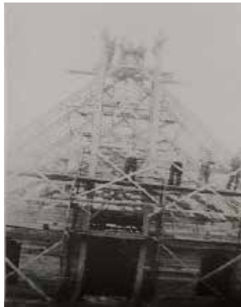
Construction de l'église à l'été 1937. Beauvais, R. (1985). op. cit. p. 84.
