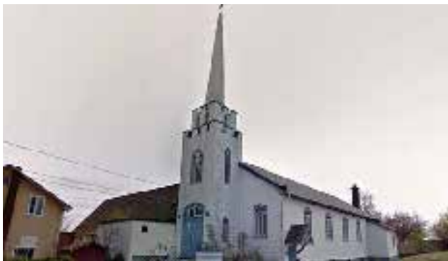
L'église All Saints Angligan (gauche) avec la façade modifiée en 1959 et le temple maçonnique (gauche). On aperçoit en arrière-plan l'église Notre-Dame-de-Protection.
