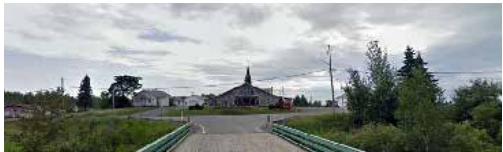
Le noyau commercial et institutionnel formé par l'église, la salle paroissiale, l'ancienne école et un commerce. Google Street View, 2019.
