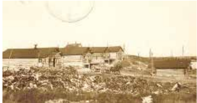
Des maisons d'un étage à toit à deux versants associés aux premières constructions sur le territoire.
