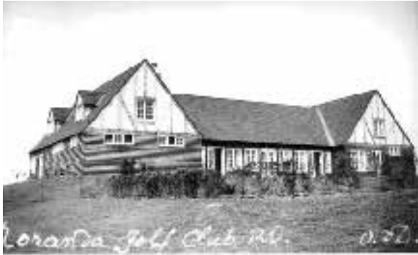
Le club de golf construit par la Noranda en 1934 Vavasour & Dick. Fonds Fonderie Horne. P123,S1,P302. BAnQ Rouyn-Noranda.
