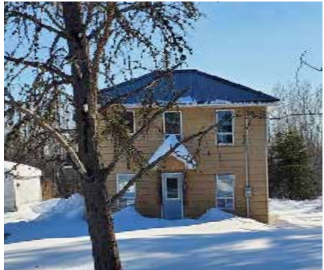
6357, rang du Quai. Bellecombe. Enclume, 2023.
