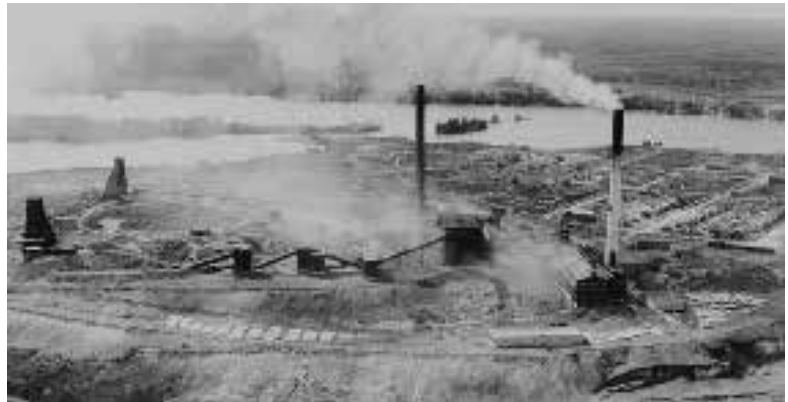
Vue aérienne de la mine Noranda (vers le sud) entre 1933 et 1937. On aperçoit les puits d'extraction, les deux cheminées et les convoyeurs couverts (de gauche à droite). Fonds Canadien National. 08Y, P213, P445. BAnQ Rouyn-Noranda.
